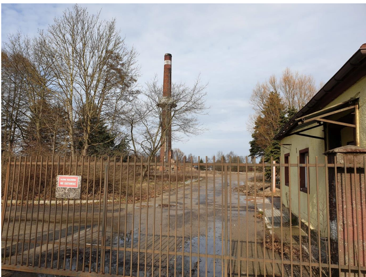
Rysunek 8. Wjazd na teren opracowania, w tle widoczny komin po nieczynnej fabryce
