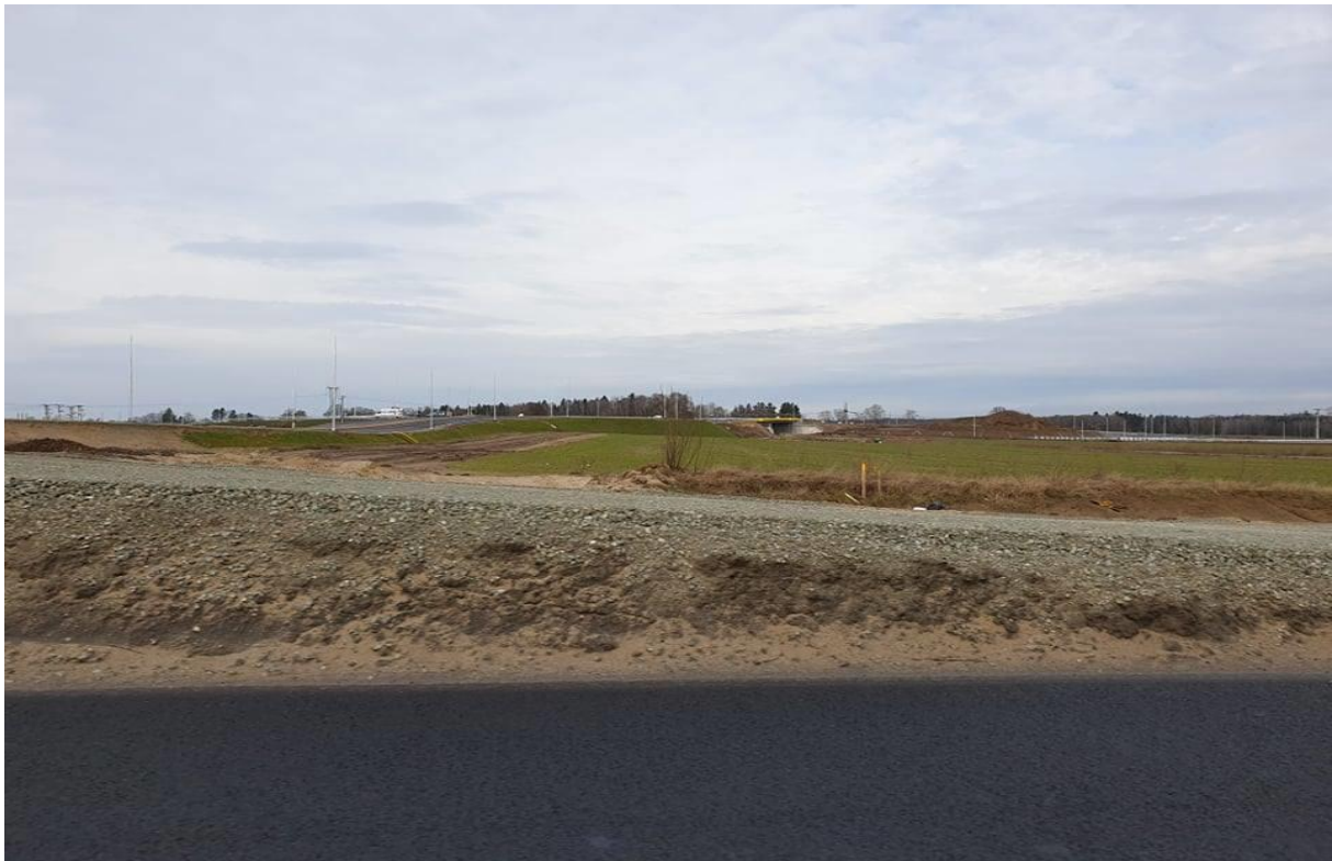
Rysunek 2. Prace trwające przy budowie drogi ekspresowej
